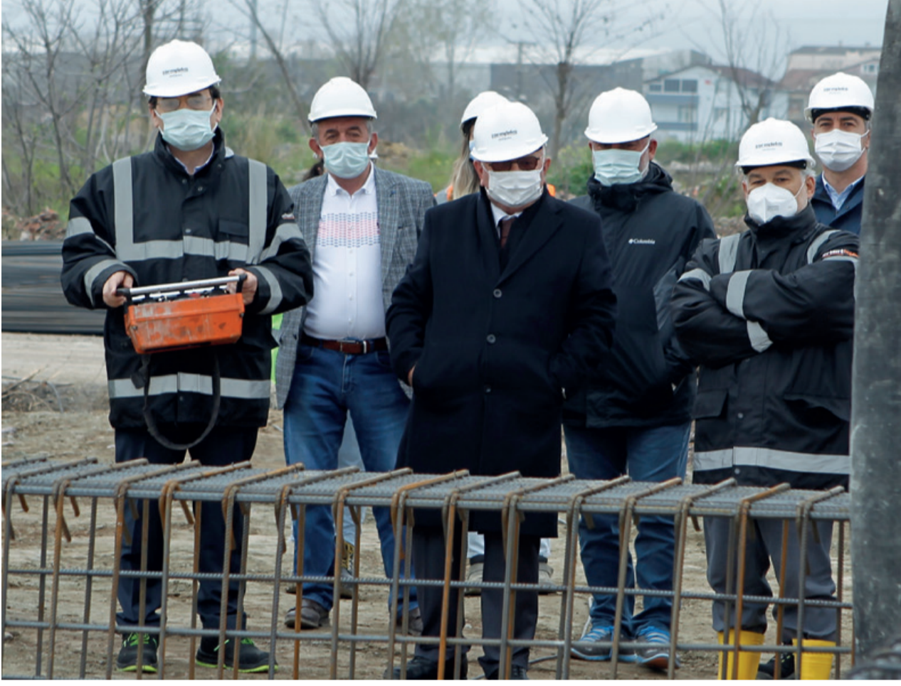
Gölcük fabrikalarımızın temeli atılırken
